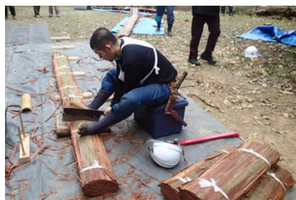
写真 3. 檜皮を束ねて 75cm に切り揃える。
