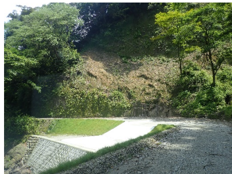
長谷林道復旧後
