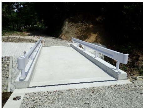
橋梁復旧状況
