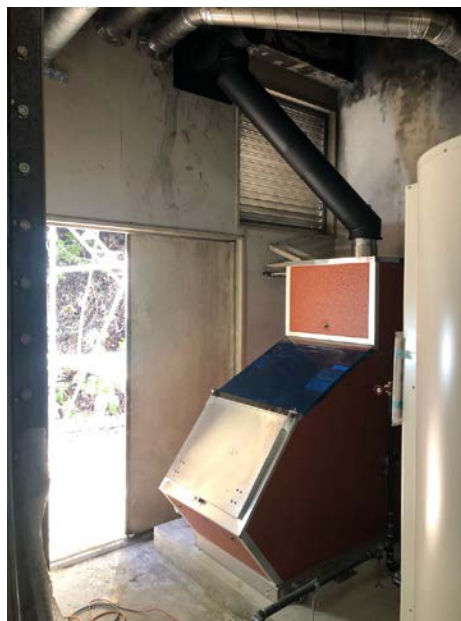
写真1 施工中のウッドボイラー (エーテーオー(株)N-500NSB2)
