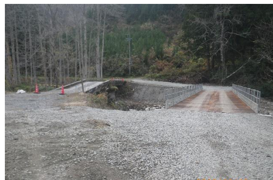
写真2. 左：被害橋 右：仮設橋
