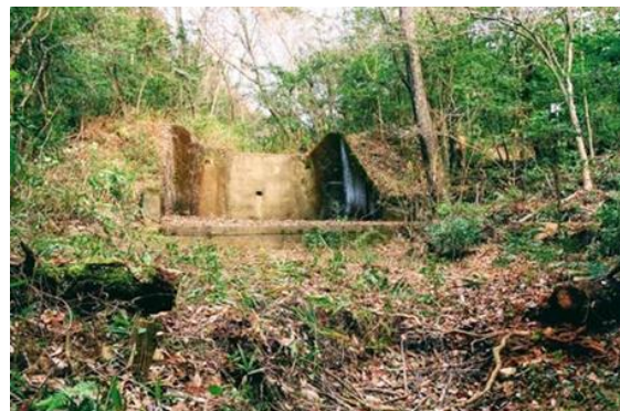
写真 2. 2016 年のコンクリート放水路付土堰堤
