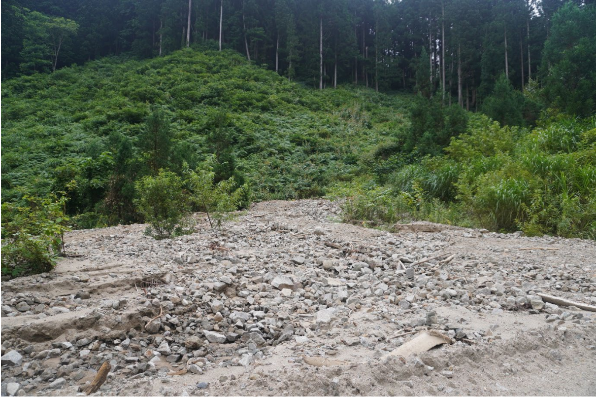
写真 河道が変わり河床堆積土砂が道路などに流出(2024年7月豪雨後に撮影)
