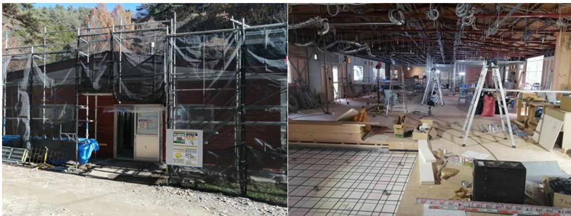
改修中の手良沢山ステーション管理棟の玄関（左）と内装（右）
