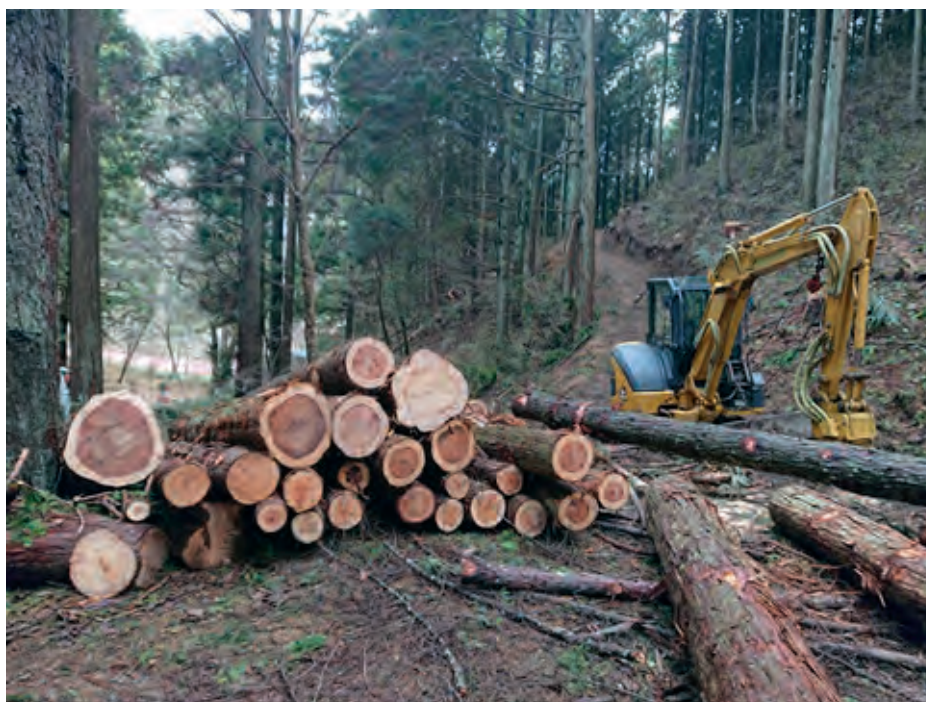
96 年生ヒノキ林における直営による林業専用道の開設と定性間伐
