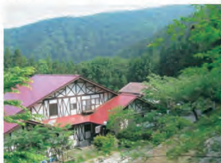
研修センター 本館
