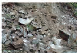
斜面から崩落した花崗岩類の岩塊
