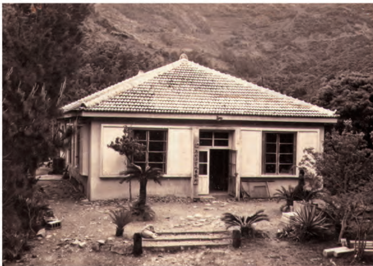
琉球大学与那演習林、竣工直後の旧演習林事務所兼学生宿舎 [1957 (昭和32)年]
