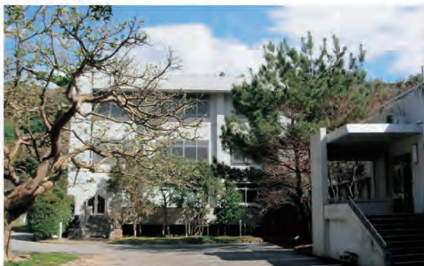
研究管理棟（正面）および宿泊棟（右）
