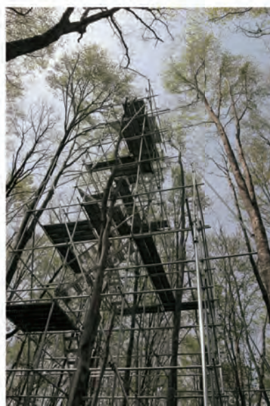
当センターの田代地区に設置した 高さ 20 m の樹冠調査用タワー
